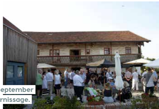
Die Stube im 1596 erbauten Zachhof.
